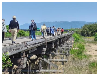
木津川流れ橋
