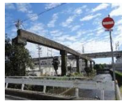
図2 川沿いの架構
