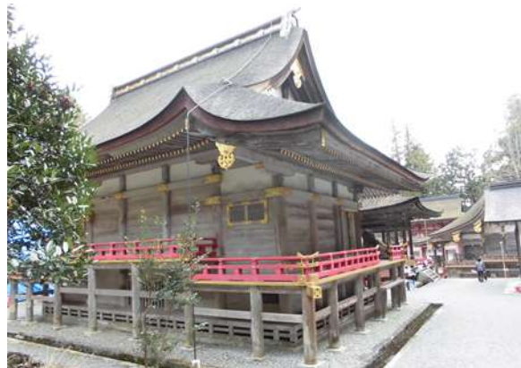
⑤ 日吉大社：東本宮本殿（国宝）「日吉造」 という独特な形で、床下にかけて仏事を 営んだ「下殿」と呼ばれる部屋がある。
