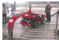
打設機：プーサー
