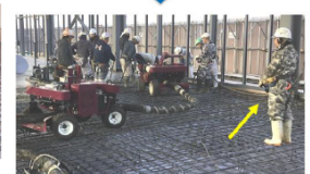
「ドラガー」による駆動型打設機 (リモコン操作)
